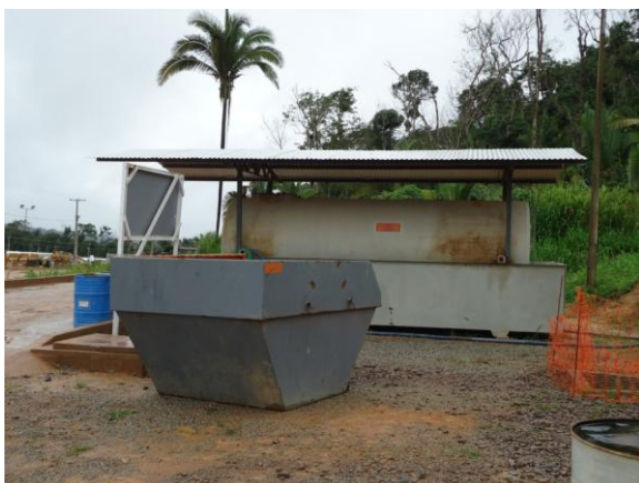
Figura 12 – Tanque estacionário de combustível
