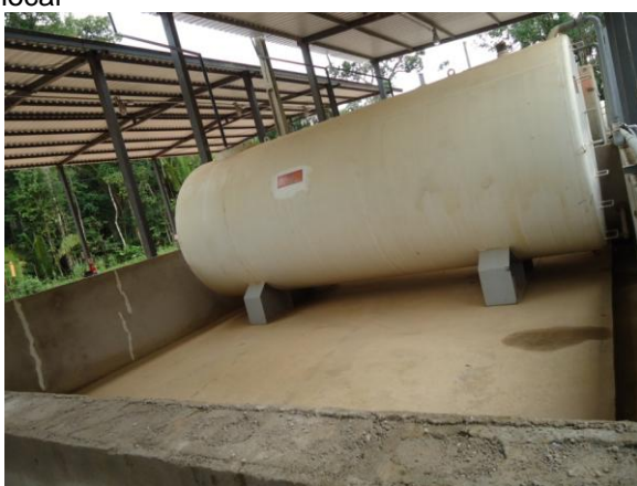
Figura 33 – Bacias de contenção construídas para controle de vazamentos
