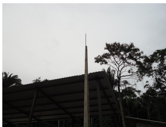
Figura 34 – Sistema de para-raios instalados na estrutura
