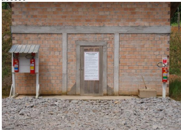
Figura 49 – Detalhe da estrutura utilizada para o armazenamento de explosivos
