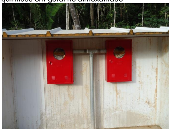
Figura 8 – Sistema de hidrantes e mangotinhos instalado no almoxarifado
