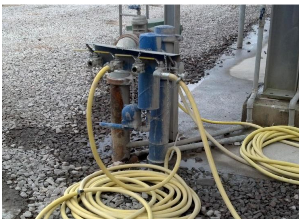
Figura 59 – Sistema de captação de água subterrânea utilizado no local
