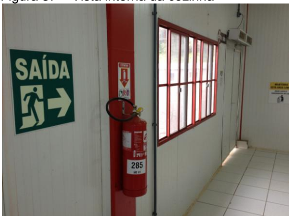
Figura 39 – Detalhe da instalação de extintores de incêndio e sinalização de emergência
