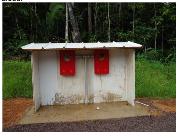
Figura 30 – Sistemas de hidrantes e mangotinhos instalados no local
