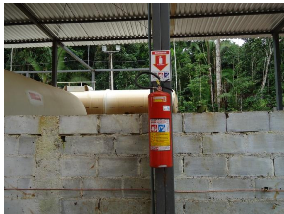
Figura 32 – Extintor de água instalado no local
