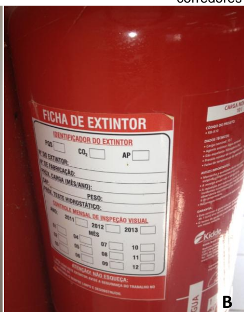
Figura 20 – Extintores de incêndio: A – Instalação dos extintores nos alojamentos; B – Ficha de inspeção não preenchida; C – Ficha de emergência preenchida com periodicidade mensal, com falhas no preenchimento
