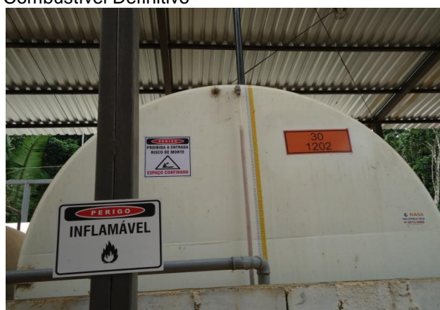
Figura 28 – Detalhe do tanque estacionário de óleo diesel
