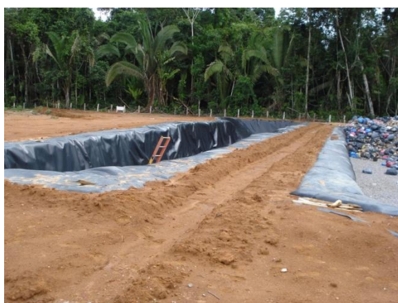
Figura 23 – Células do aterro sanitário
