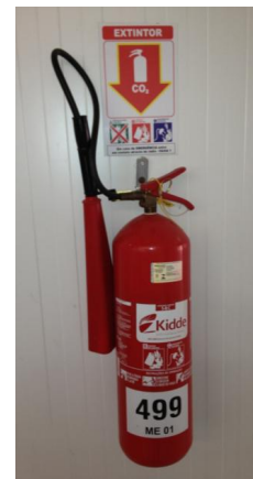
Figura 15 – Instalação de extintores de incêndio na estrutura
