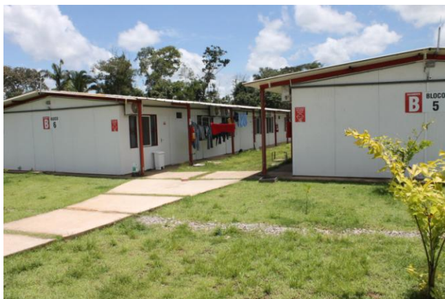
Figura 18 – Disposição dos extintores de incêndio nos alojamentos tipo B
