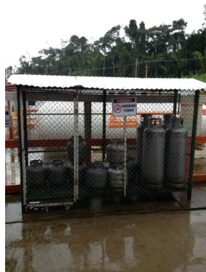
Figura 36 – Acomodação dos cilindros de GLP
