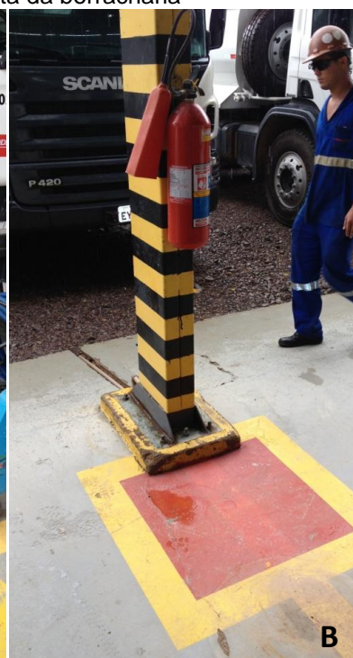
Figura 45 – Disposição de extintores de incêndio na oficina (A e B)
